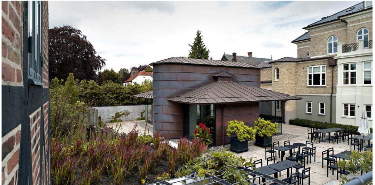
BEJSTLIGT. Den nytegnede frokoststue af Erik Møller Arkitekter er udenpå beklædt med tobak og indeni med islandske lavasten, der giver pavillonbygningen en fremragende dæmpet akustik. Tilbygningens formsprog og flade udhængende tag knytter sig til et tidligere kapel i det store gule 'Valbyhus'. Denne italiensk inspirerede villa tjente i 1925-42 som bolig for landets katolske biskop. I dag bebos Københavns tidligere bisp Erik Norman Svensen husets taglejlighed. Foto: Jens Lindhe
